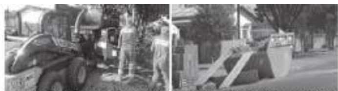
Figura 26 - Exemplos do acondicionamento do RV e RVol: (A) Redução de dimensão dos RV para acondicionamento; e (B) Capamba utilizada para acondicionamento de RVol.
